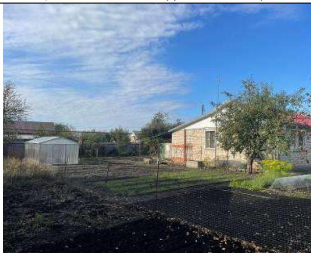
Фото 3 Общий вид объекта оценки
