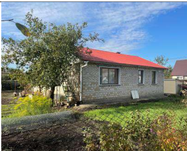
Фото 2 Общий вид объекта оценки
