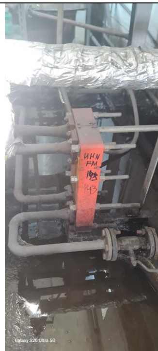
Теплообменник пластичный ТИ 056-12, инв. № FM-000143 75
